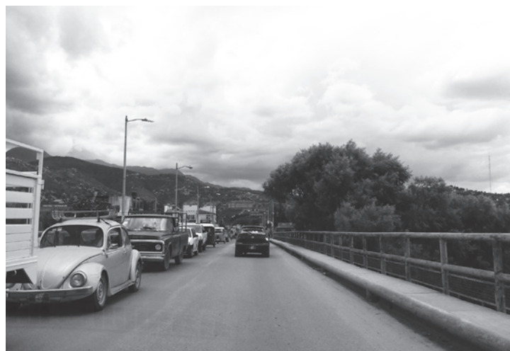
Figura 3: ponte para a travessia do Rio Atoyac. Fonte: arquivo da autora
