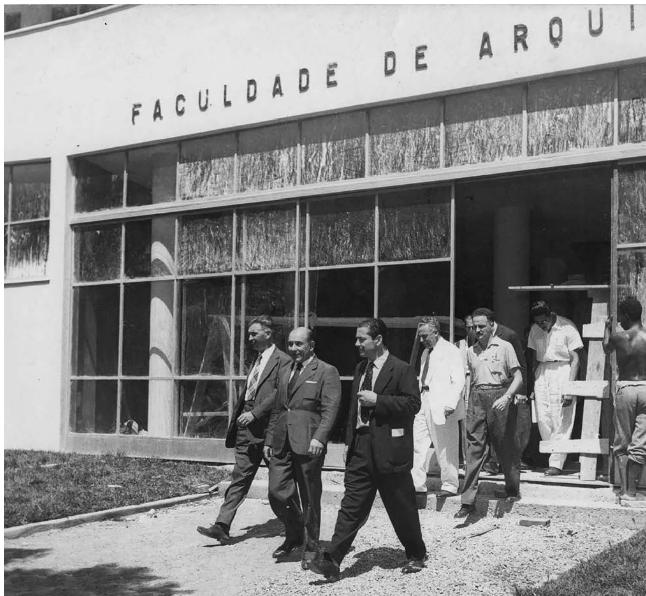
Figura 03: Visita do Sr. Leonel Brizola (prefeito de Porto Alegre) ao prédio da Faculdade de Arquitetura, em construção, no final da década de 1950.
