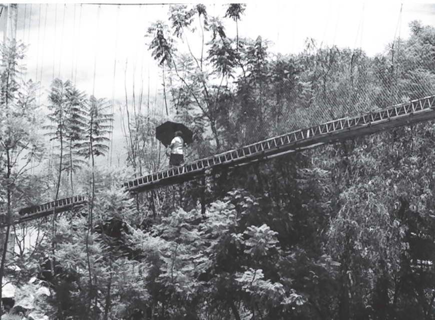
Figura 1: ponte pênsil peatonal para a travessia do Rio Atoyac. Fonte: arquivo da autora
