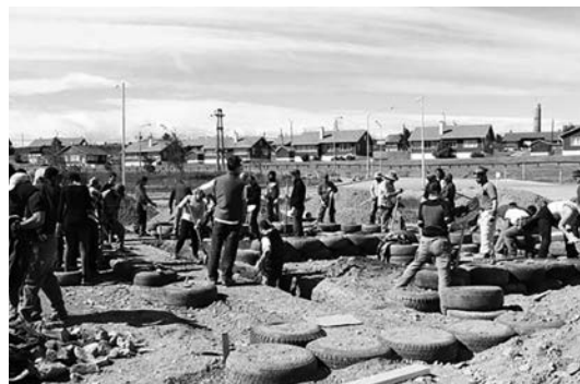
Figura 4: Paredes de Pneus. Fonte: acervo pessoal
