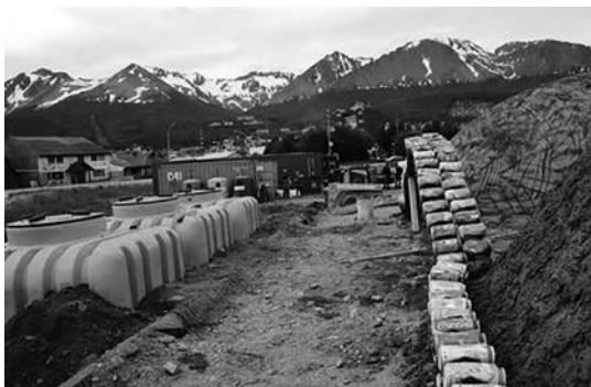
Figura 7: Cisternas Enterradas. Fonte: acervo pessoal
